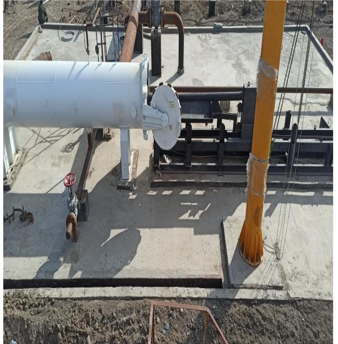
Строительство камеры приема-пуска СОид на ПСП 1235 км нефтепровода Узень-Атырау-Самара
